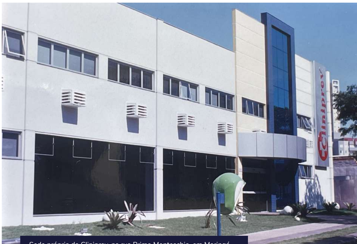
Sede própria da Cliniprev, na rua Primo Monteschio, em Maringá
