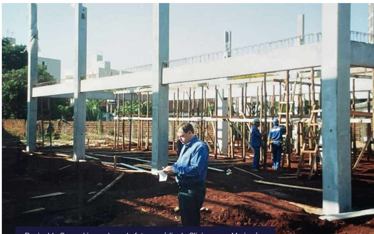
Reginaldo Czezacki nas obras do futuro prédio da Cliniprev em Maringá
