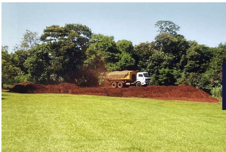
Obras do Crematório Angelus, em Maringá
